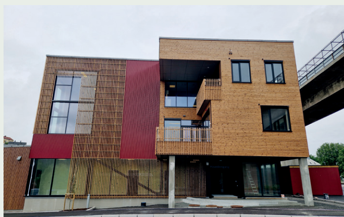
Fasade mot sør. Norsundbrua passerer nesten helt inntil bygget.
